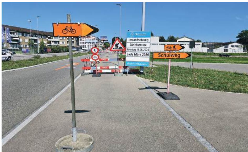
Ab 19. August 2024 ist die Zürichstrasse im Dorfkern von Brüttisellen nur einspurig befahrbar. Sie wird saniert. Der Verkehr wird umgeleitet und durch Lichtsignale gesteuert. Die Arbeiten dauern bis Ende März 2026.
