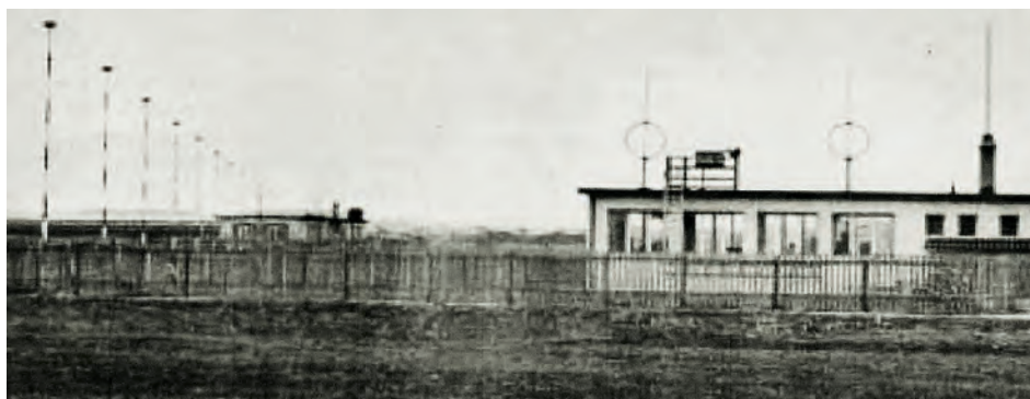
Anflug auf den Flugplatz Dübendorf 1935. Ganz links die Anflugbefeuerung, im Hintergrund die Funkstation, rechts das Peilerhaus mit den Rahmenantennen des Impulsfernpeilers links, des Anflugpeilers rechts und ganz rechts die Antenne für die Seitenbestimmung der Peilungen.
