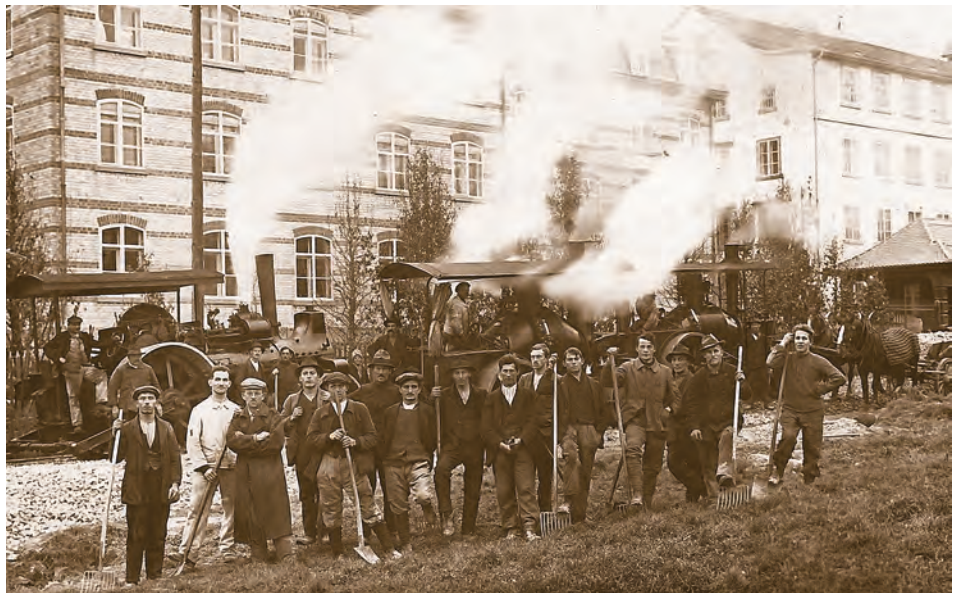
Arbeiter der Schuhfabrik werden 1931 bei der Asphaltierung der Zürichstrasse eingesetzt.
