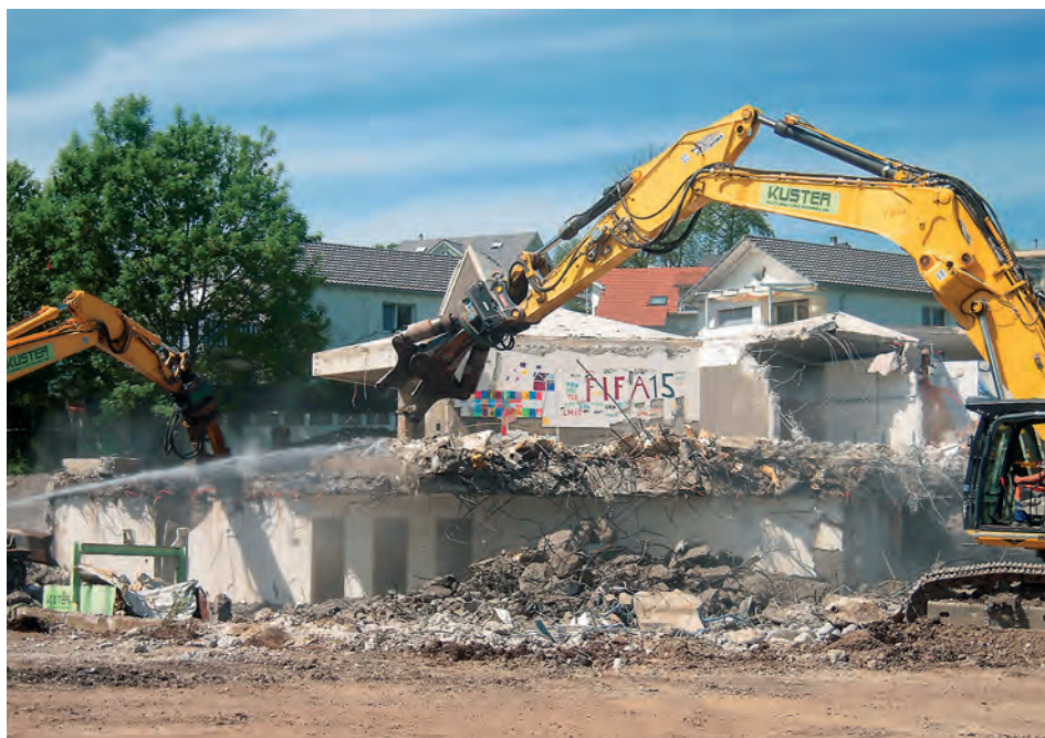
Da stand doch mal ein Schulhaus: Abbruch des Schulhauses Oberwisen im Mai 2015.
